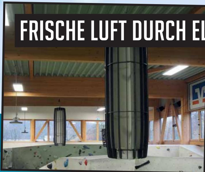
Saubere Luft bedeutet mehr Power zum Klettern. Die neuen Staticair-Elemente reinigen seit Februar zusätzlich zur Lüftungsanlage die Luft im B12 mit elektrostatischer Anziehungskraft.
