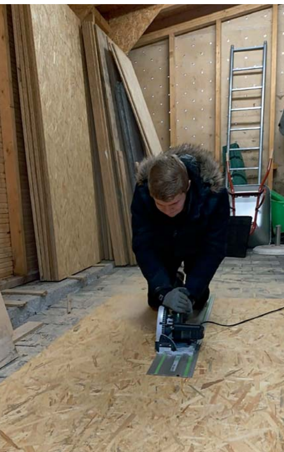
Hier schneide ich mit einer Kreissäge eine Holzplatte für das neue Lager unter der Treppe zu.
