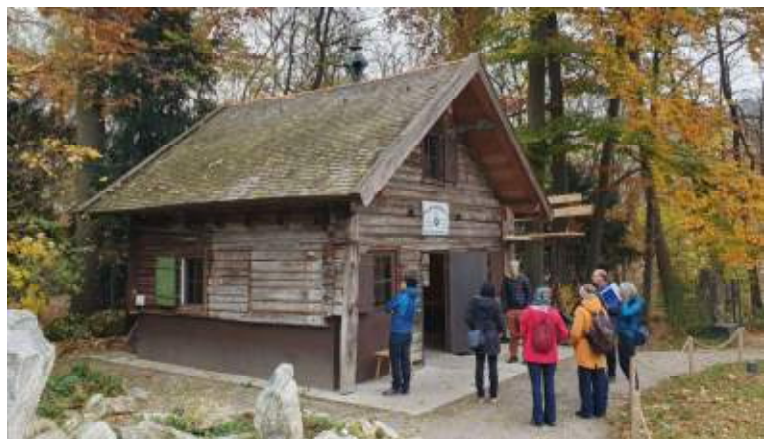
Die wieder aufgebaute Höllentalangerhütte im Garten des Alpinen Museums
